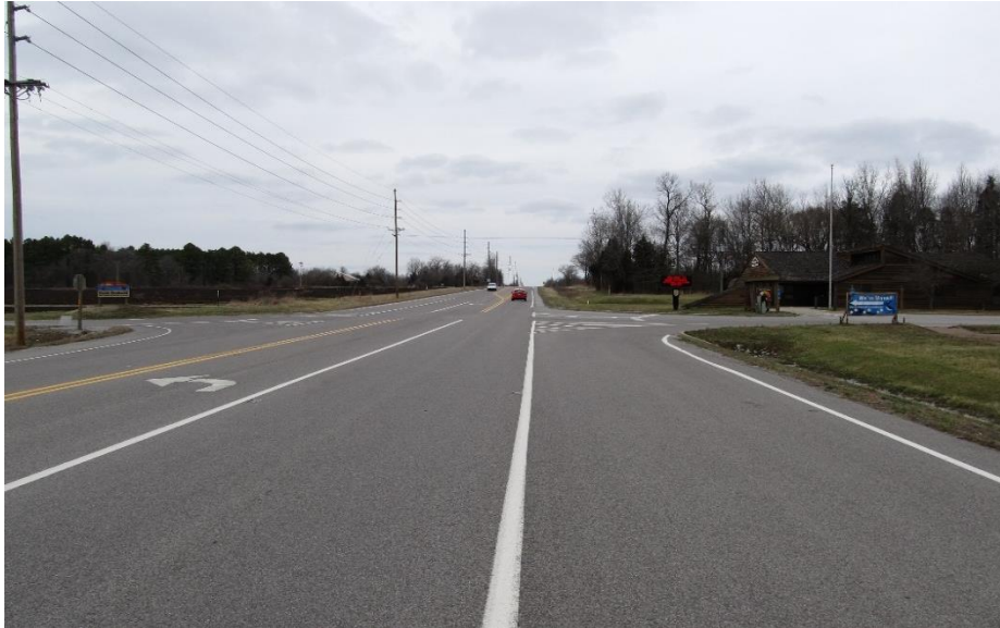
IL 148 - Looking North
